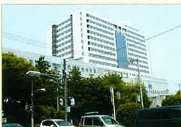
建設進む新病院
